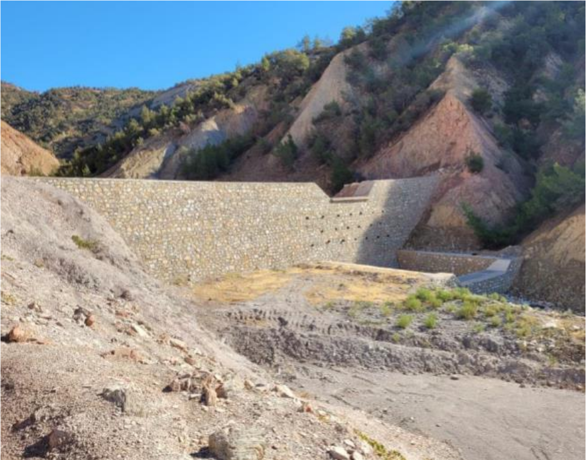
Fotoğraflar 12 Tesisin İçinden Geçen Mevsimlik Dere Üzerine Yapılan Dolgu Barajından Görünüm
