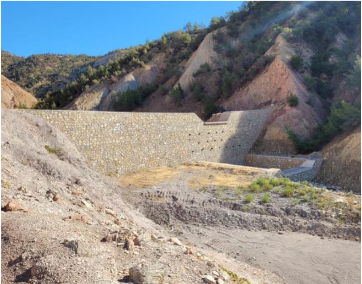
Fotoğraflar 5 Tesisin İçinden Geçen Mevsimlik Dere Üzerine Yapılan Dolgu Barajından Görünüm
