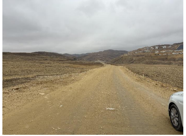
ZDM-2 Kuyu Lokasyonuna Erişim Yolu
