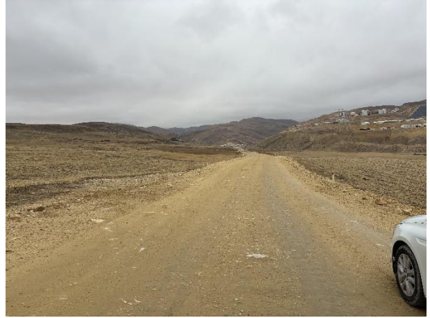
ZDM-2 Kuyu Lokasyonuna Erişim Yolu
