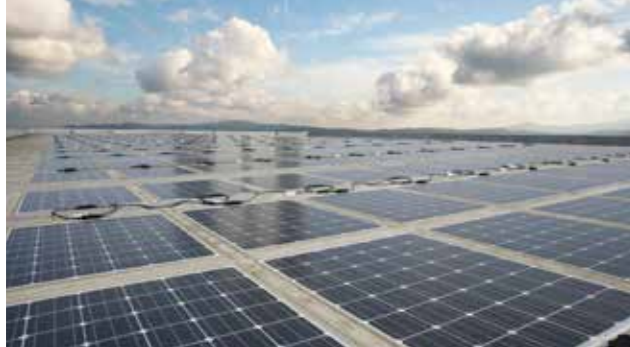
Membran çatı uygulaması, 900 kWp kapasiteli İstanbul, Türkiye
