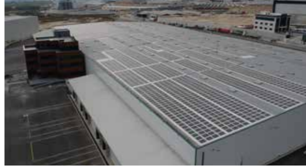
Membran çatı uygulaması, 1000 kWp kapasiteli Mersin, Türkiye
