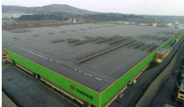
Dünyanın en büyük ince-film çatı kurulumu, 10000 kWp kapasite Osmaniye, Türkiye
