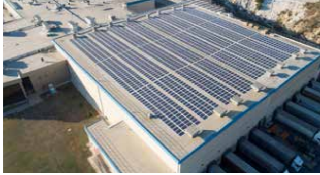
Cips üretim tesisi, 518 kWp kapasiteli Mersin, Türkiye
